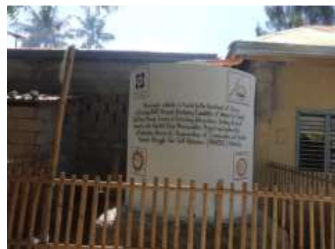
Showcase of ferrocement tank in Sagasa Island, Bien Unido.
